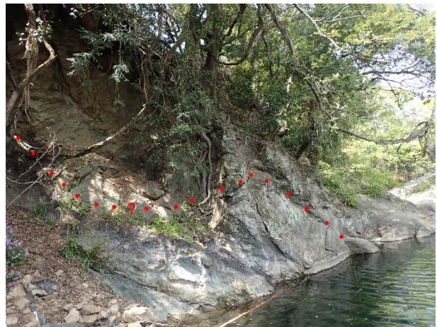
図 29 大北野-岩山線（左岸から）
